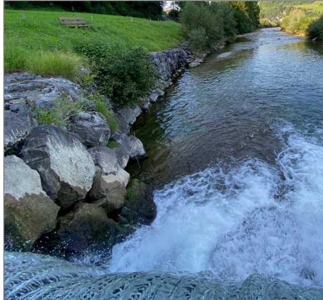
Abb. 10 BESTEHENDE UFERVERBAUUNGEN LINKES UFER, OBERSTROM UND UNTERSTROM DER SPERRE
