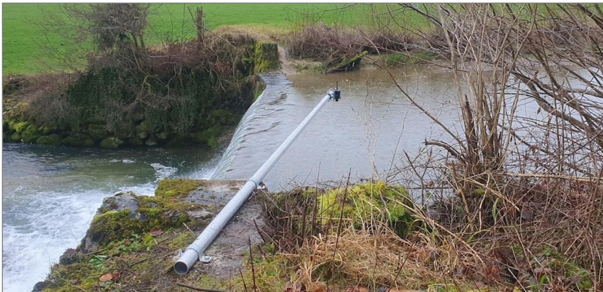
Abb. 23 PEGELMESSSTATION BEI DER SPERRE
