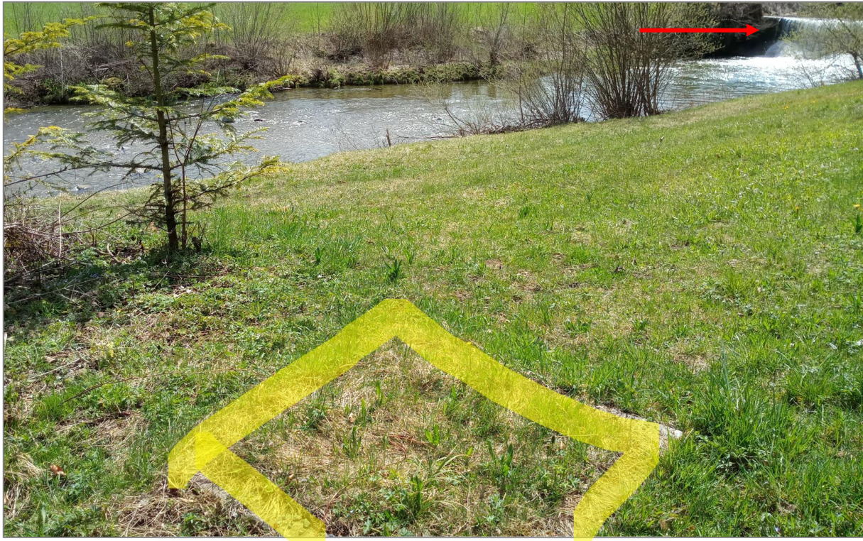
Abb. 22 SCHACHT UBK, VORNE IM BILD, HINTEN IST DIE SPERRE SICHTBAR
