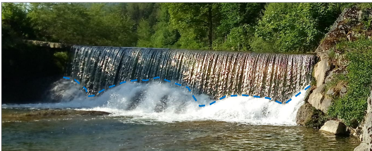
Abb. 17 FELSVERLAUF UND NATÜRLICHES WASSERSPIEL IM SPERRENBEREICH
