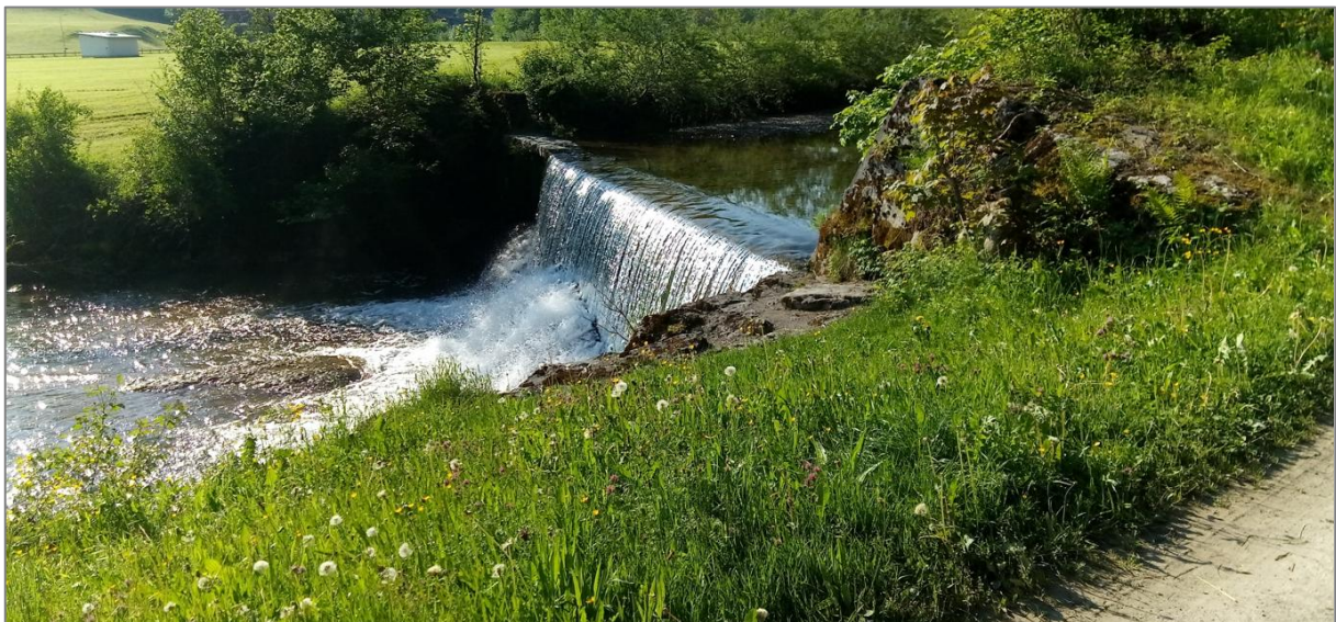
Abb. 7 ABSTURZBAUWERK, ANSICHT VON UNTERSTROM, IM HINTERGRUND DAS GW-PUMPWERK
